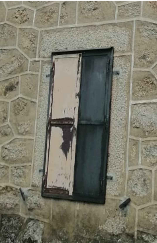
VENTANAS PLANTA BAJA EN MADERA. CON POSTIGO METÁLICO COMPLETO
