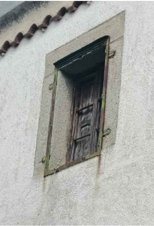
VENTANAS PLANTA ALTA EN MADERA. EL MARCO DE LOS POSTIGOS METÁLICOS, FALTAN LAS HOJAS
