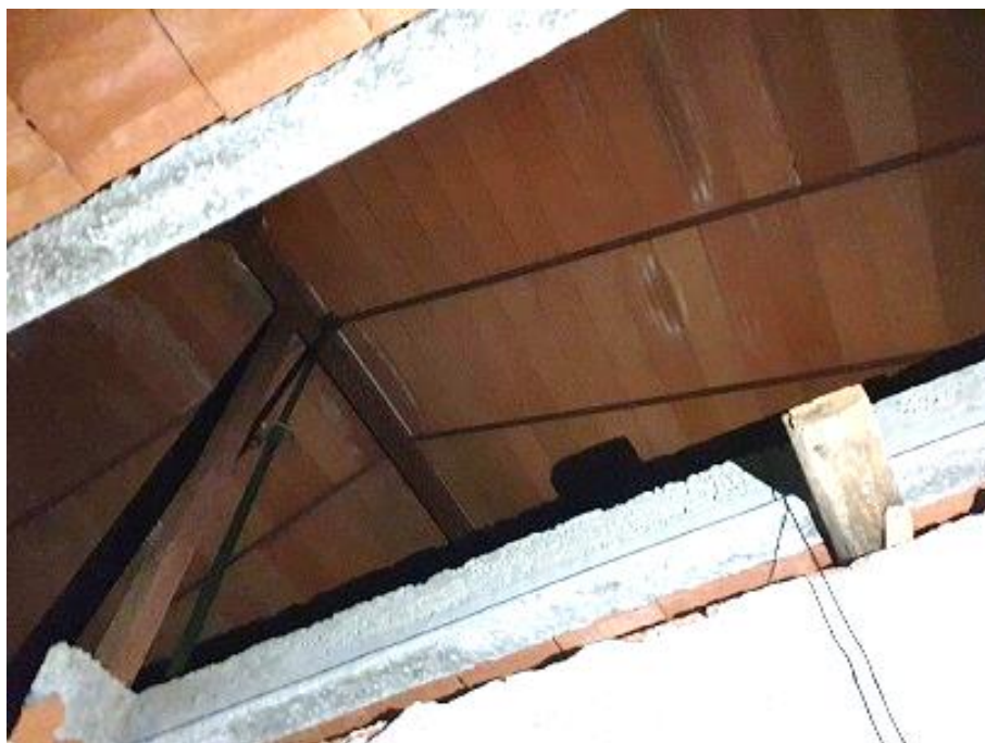
Estructura cubierta y hueco en forjado previsto para escalera acceso al bajocubierta
