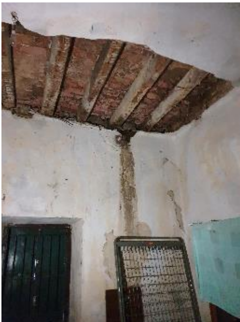
Forjados de la planta baja deteriorados por filtraciones de agua.
