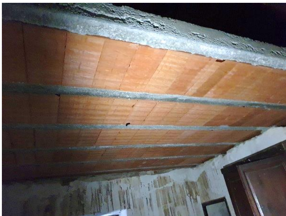
Forjado bajocubierta
