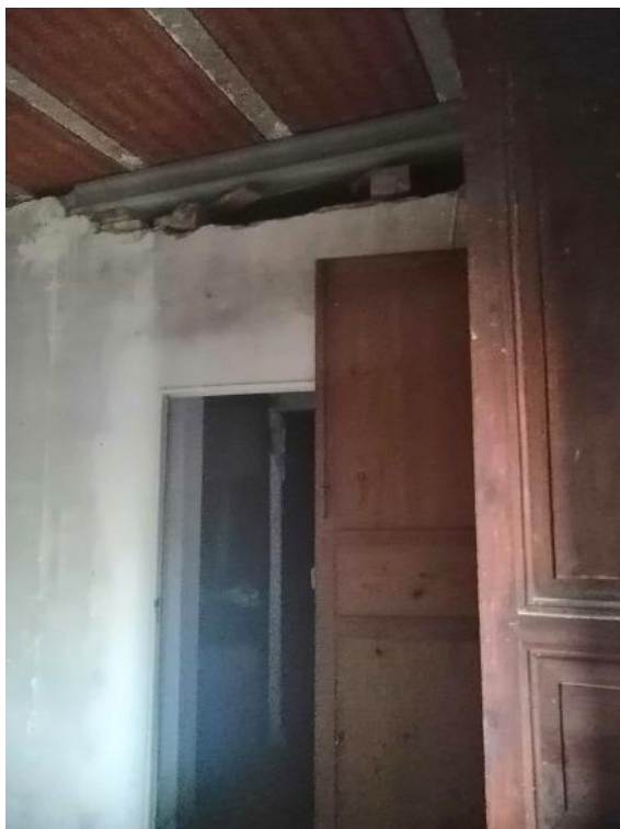
Encuentro de forjado bajo cubierta con muro y tabique
